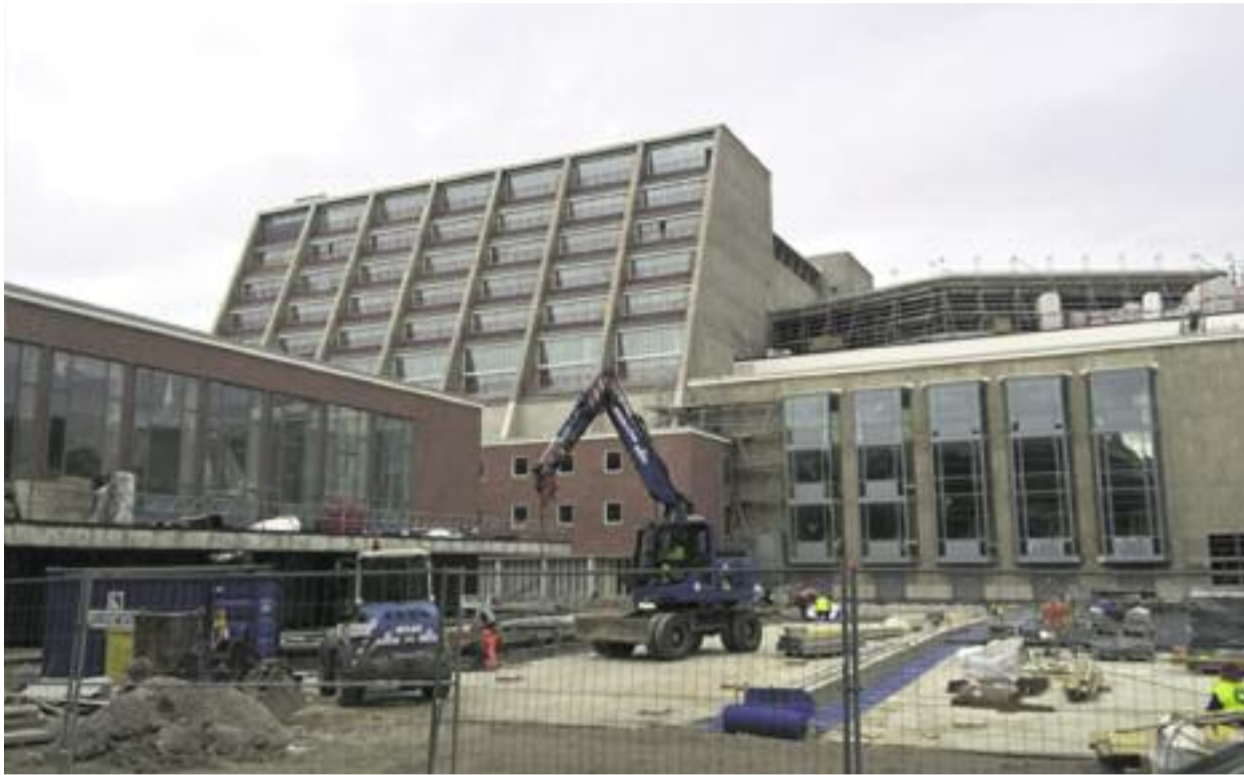
Langwierige Dauerbaustelle: Das denkmalgeschützte Kölner Opernhaus
