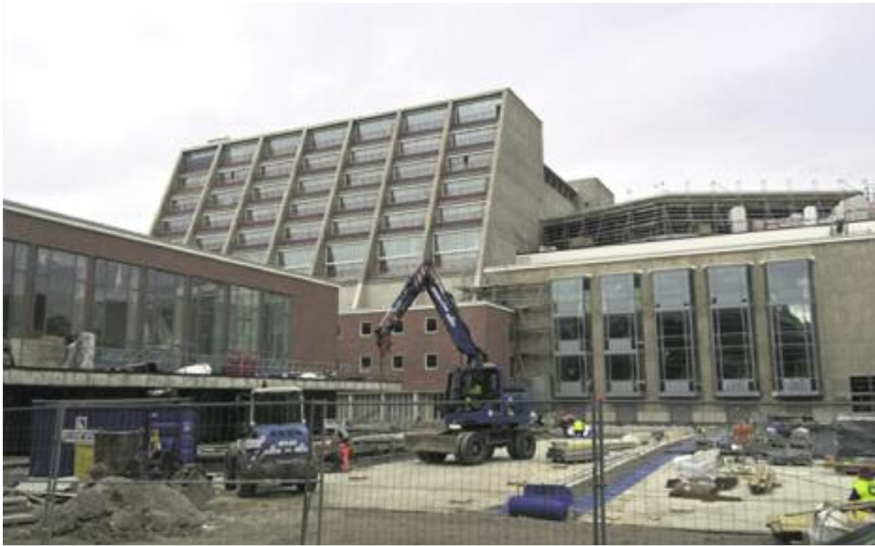
Langwierige Dauerbaustelle: Das denkmalgeschützte Kölner Opernhaus
